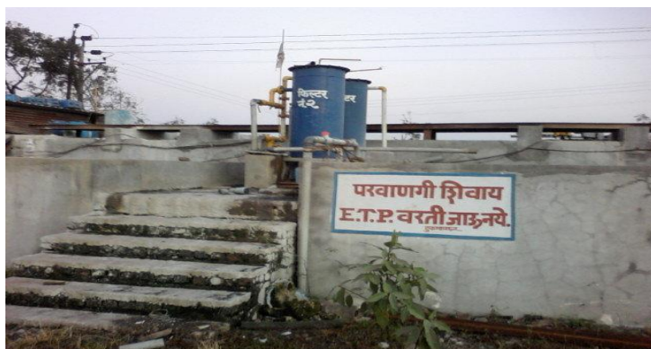
Fig. 1:- Raw Effluent Tank.
